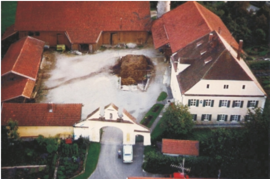
Pfarrhof Binabiburg um 1970. Links: Stall/Schupfe erbaut 1690. Mitte: Stadel erbaut 1903. Rechts: Anbau an das Pfarrhaus, der Stall mit heizbarer Knecht-kammer, erbaut 1897. Pfarrhaus mit dem barocken Hofportal, erbaut 1690.
