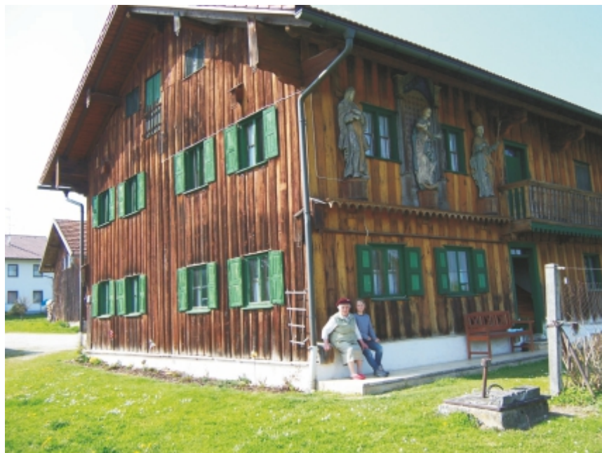
Der ehemalige Sitz Binabiburg, der „Sedlbauer“ mit den drei Heiligenfiguren an der Südseite. Hier wurde einmal Schulunterricht gehalten. Foto Juni 2010, Peter Käser.
