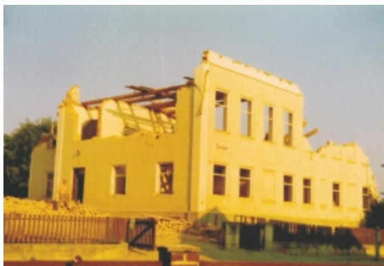
Schule Binabiburg, Abbruch 1981.
